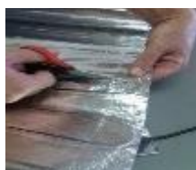
Konec stříhu. POZOR na kabel!
